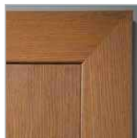
łączenie opasek pod kątem 45°
