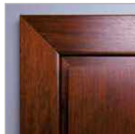
łączenie opasek pod kątem 45°
