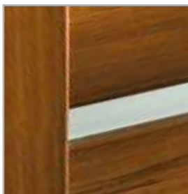
połączenie ramiaka, paneli i szyby
