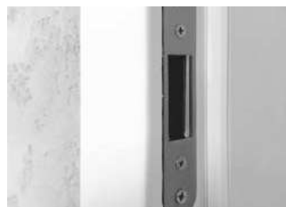
zaczep zamka magnetycznego w ościeżnicy
