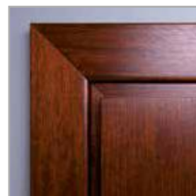
łączenie opasek pod kątem 45°
